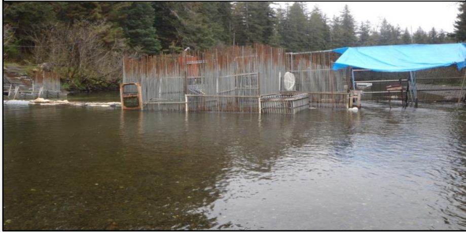
Situk River weir
